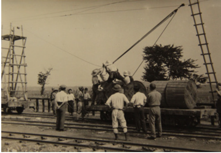
電化工事の様子
